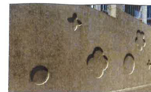
reference technologie otisku vzoru do betonu přes polyuretanovou matici
